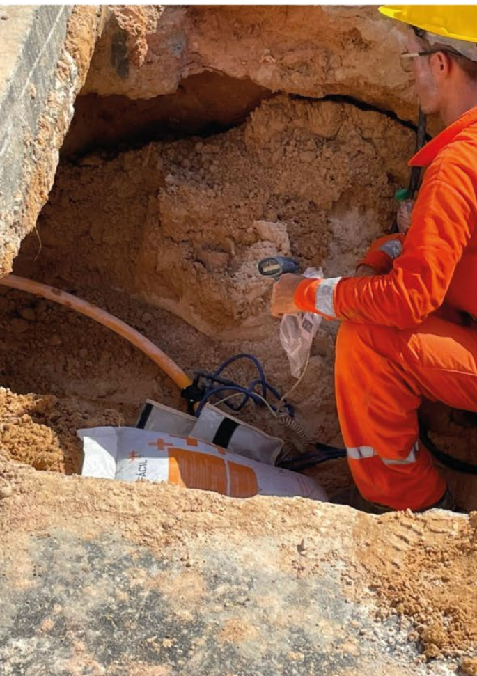
Imagem 1: Eletro fusão da tubulação em PEAD. Fonte: ARSEPAM/2022.
