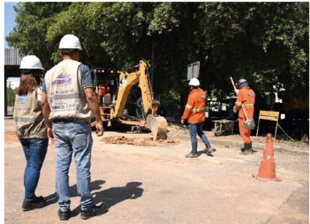
Imagem 4: Escavação para coluna de tubulação. Fonte: ARSEPAM/2022.
