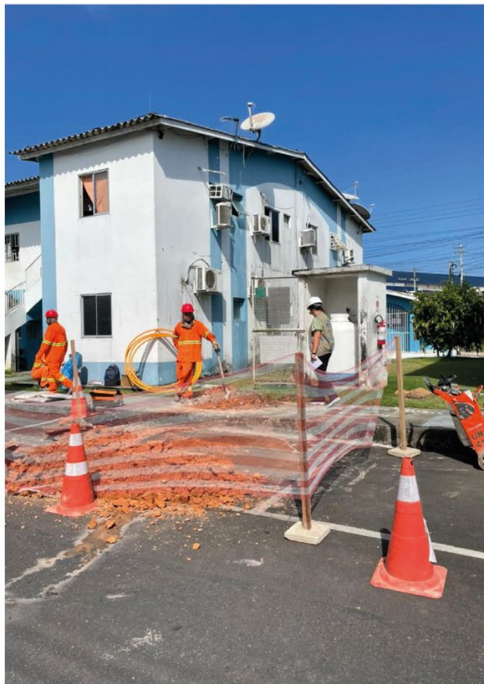
Imagem 2: Isolamento da interligação da rede principal com a rede interna. Fonte: ARSEPAM/2022.
